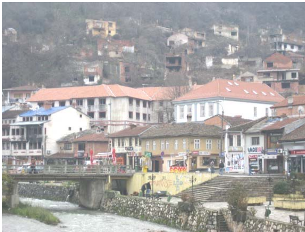
Поглед на зграде православне Богословије. С десне стране се види већ скоро завршени објекат Задужбине Симе Игуманова, а с леве стране су Деканат и Интернат који су покривени кровом како би се заштитили од даљег пропадања. Њихова обнова треба да почне у 2008.
