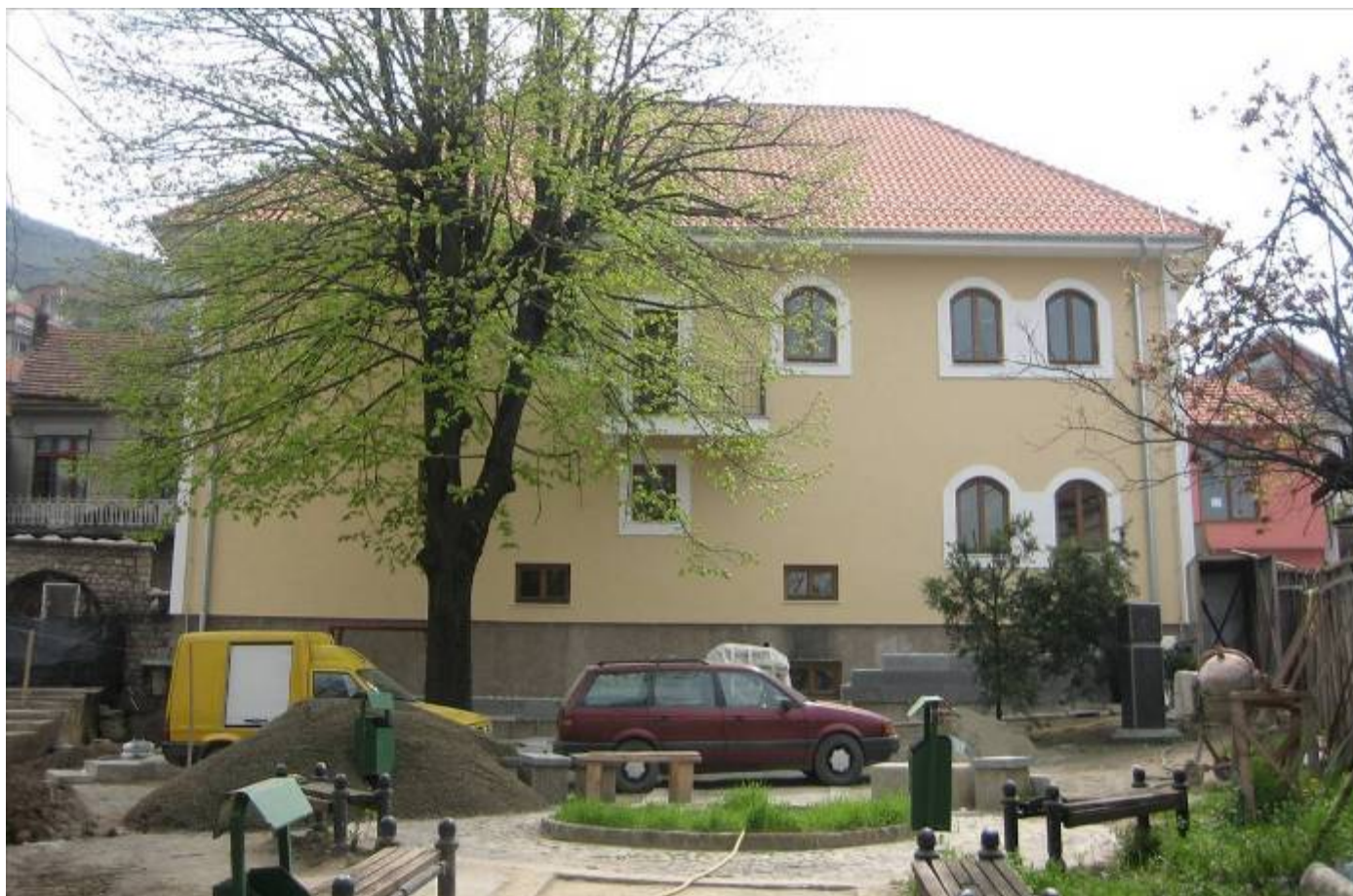
Северна фасада ново-обновљеног Владичанског двора у Призрену, април 2008.
