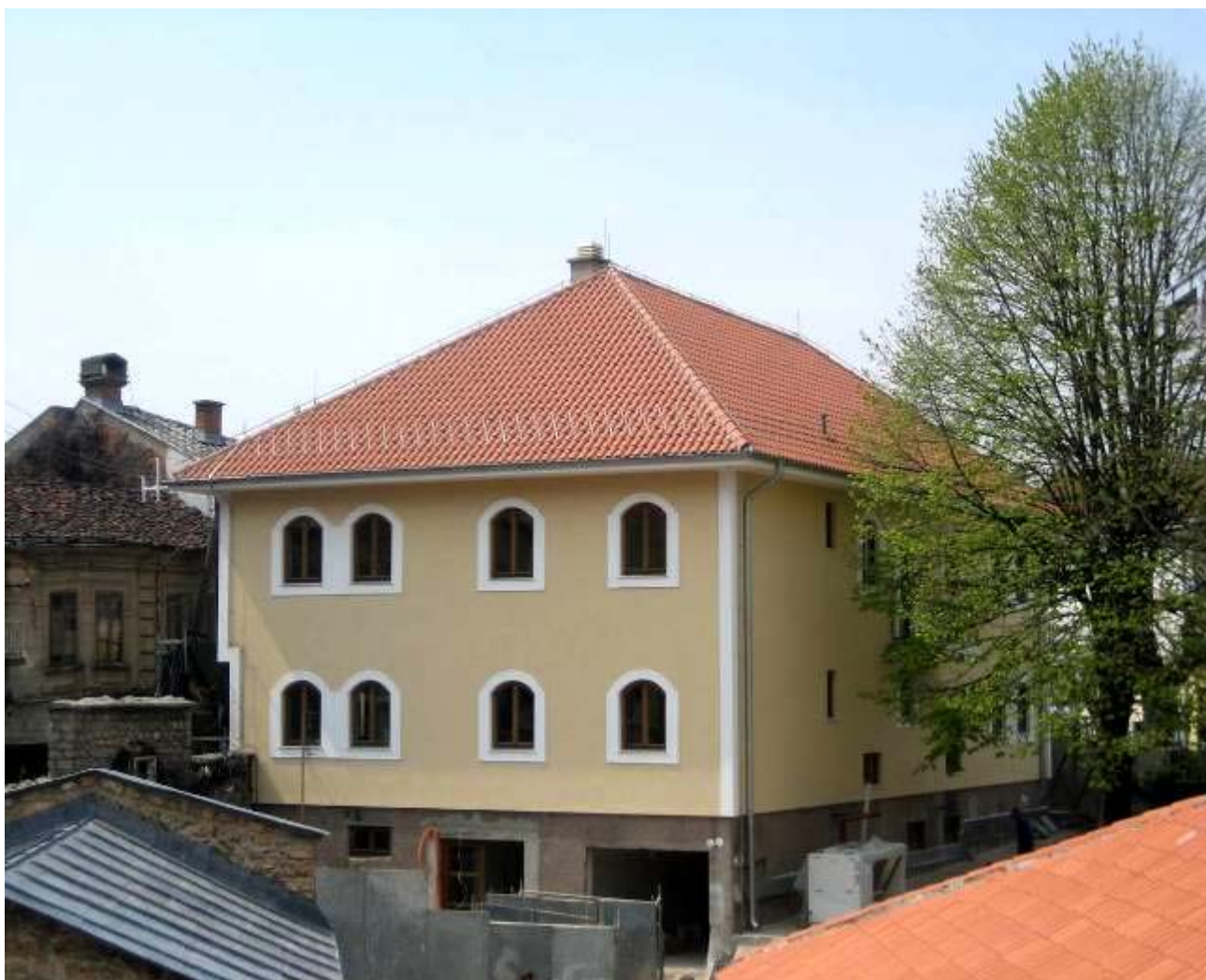
Поглед на источну фасаду Владичанског двора у Призрену (април 2008.)
