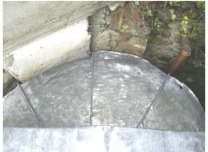
Поправка на крову цркве после крађе оловног покривача 2007. године
