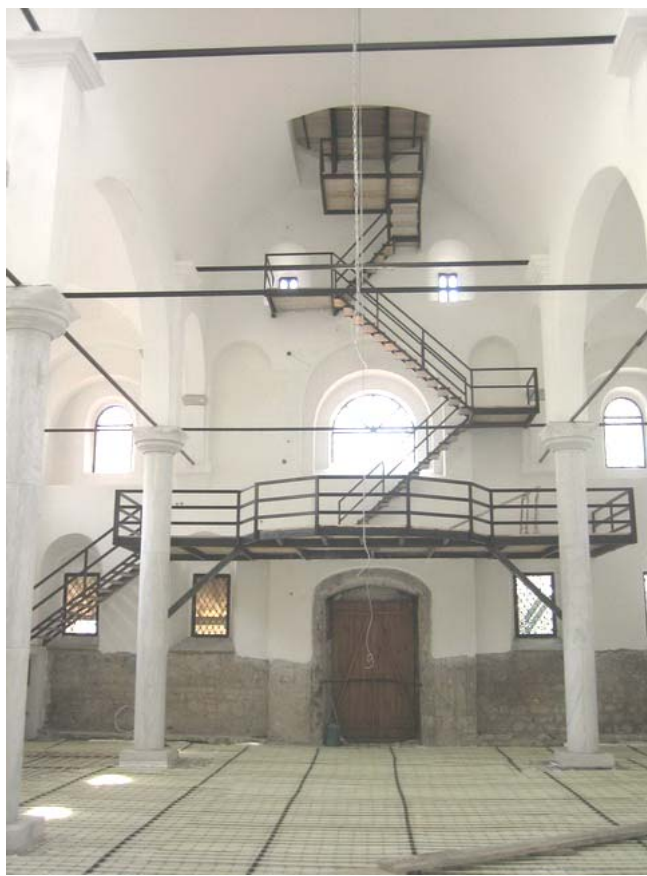
Изглед унутрашњости храма, Св. Ђорђа, март 2004 – постављање система подног грејања
