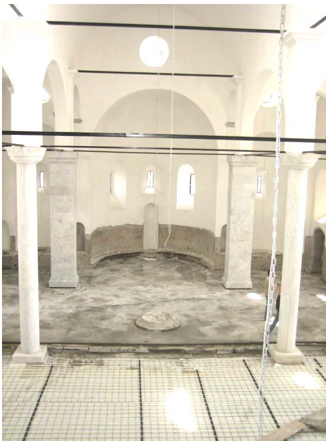
Изглед унутрашњости храма, Св. Ђорђа, март 2004 – постављање система подног грејања
